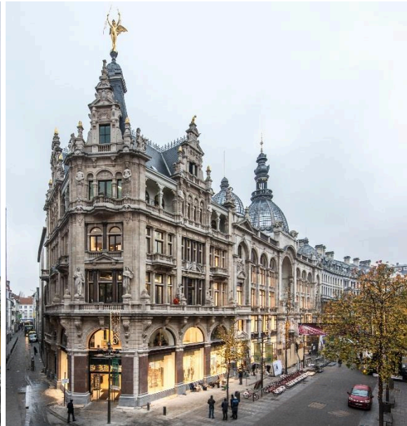
Photo après la restauration (déc. 2014)
