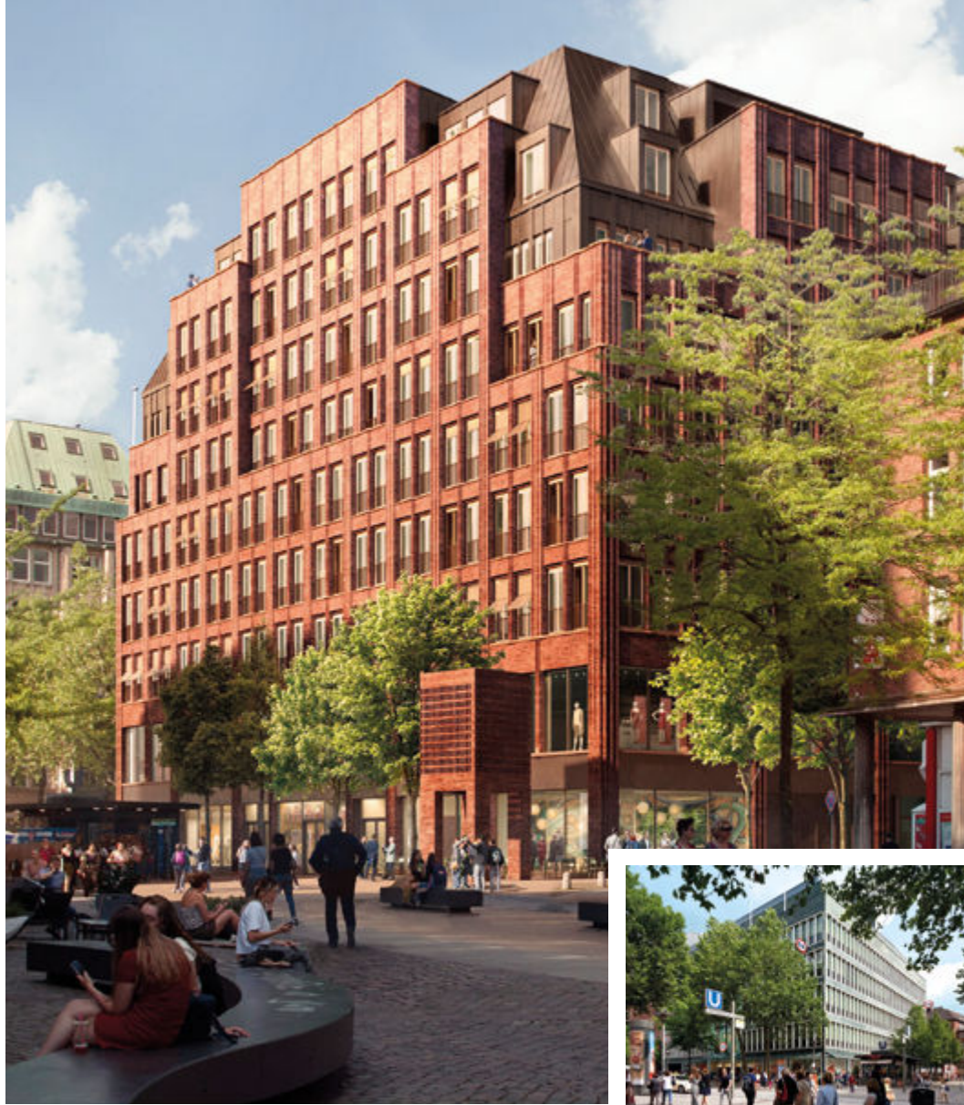
Sergison Bates architects/rethmeierschlaich architekten
