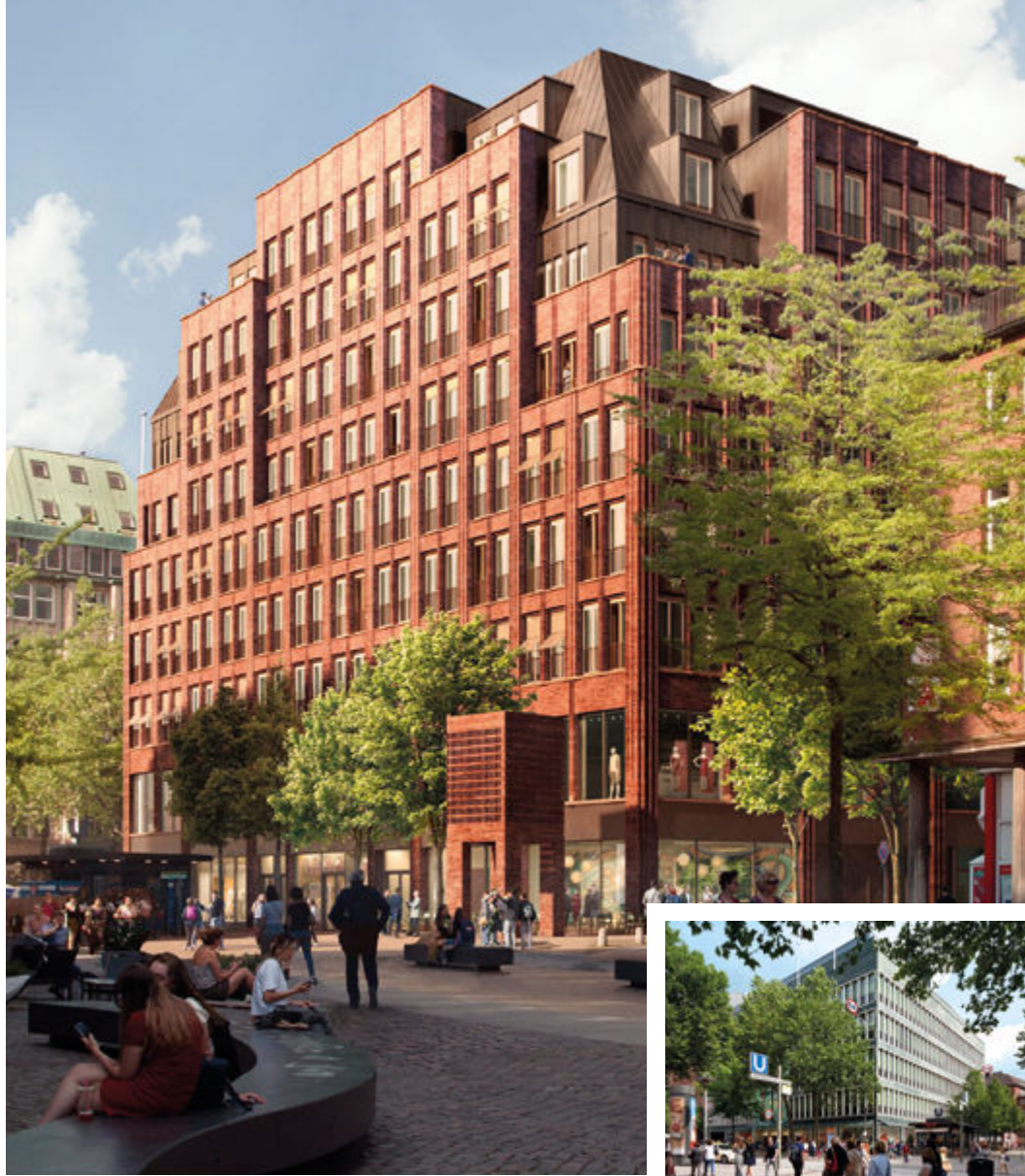
Sergison Bates architects/rethmeierschlaich architekten
